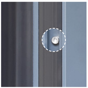
Eine Falzabdeckleiste schließt elegant den Falzbereich. Die Abbildung zeigt einen Ausschnitt ohne/mit Abdeckung.
